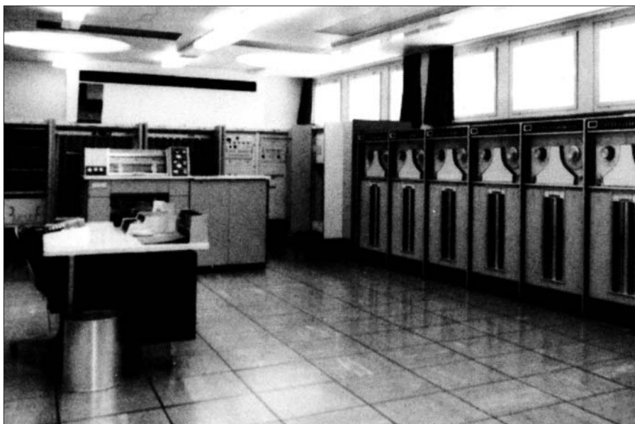
Das erste Rechenzentrum des Kantons wurde 1964 in Miséricorde eingerichtet, dort wo sich heute der Service Informatique der Universität befindet.
