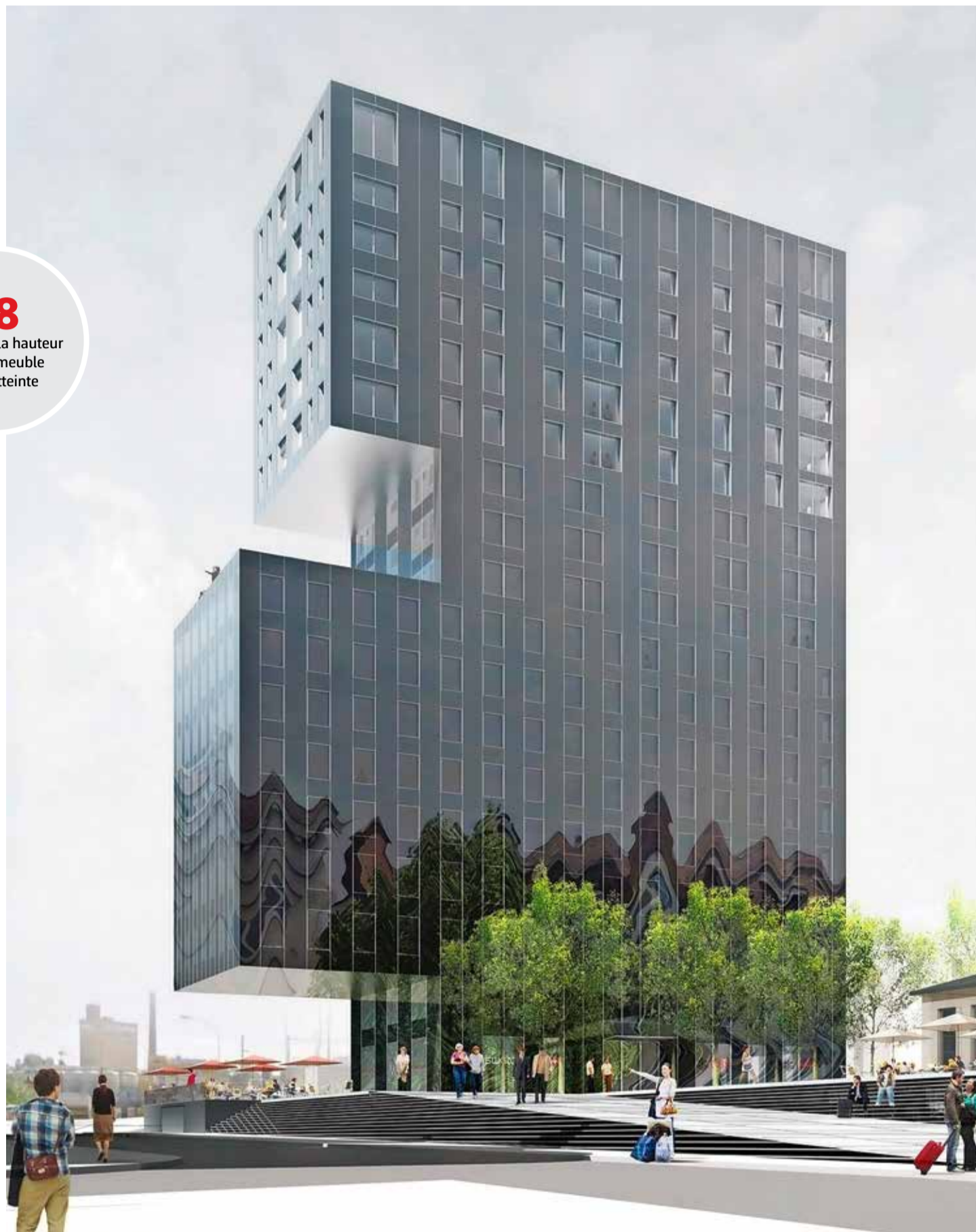
Présentée en 2012, la tour de l'Esplanade aurait déjà dû émerger. Dominique Perrault Architecte/DR
