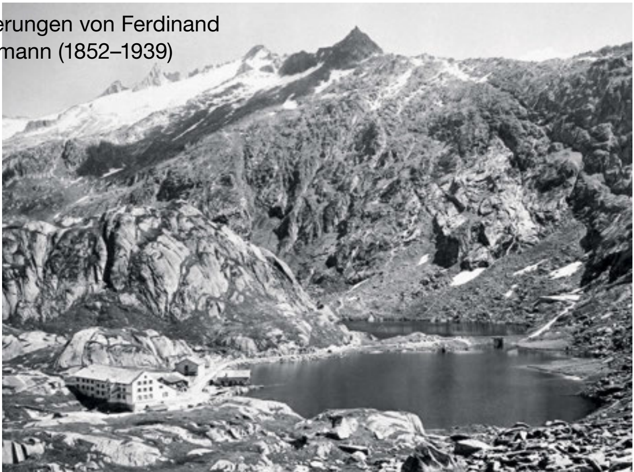
Über das Nägelisgrätli erreichte Lindemann mit den zwei Bergführern das alte Grimsel Hospiz. Foto: plattformj.ch
