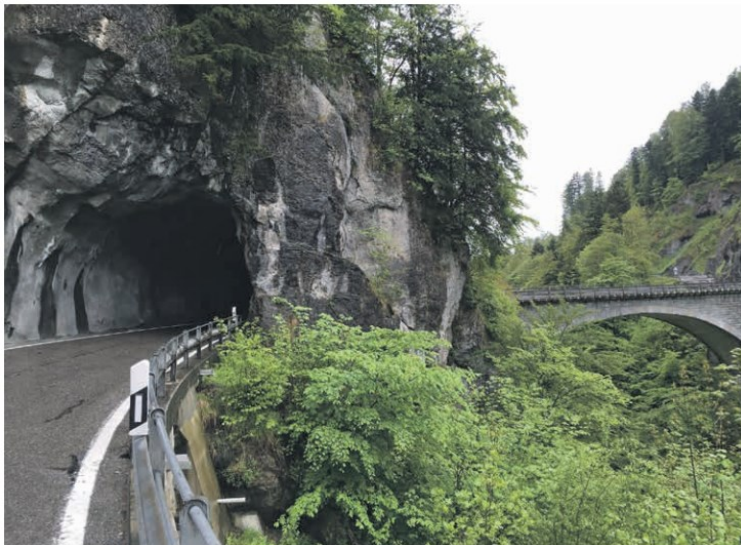
Chlusstaldentunnel und Chlusstaldenbrücke eingangs der Lammschlucht (Abstimmungsbroschüre, S. 23)
