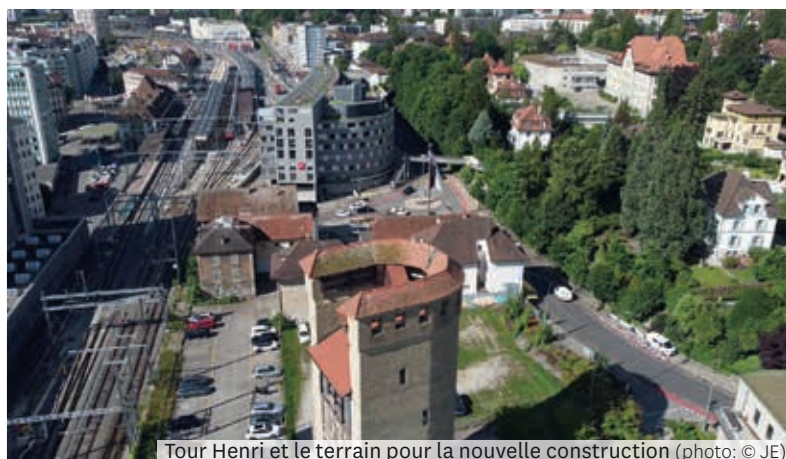
Tour Henri et le terrain pour la nouvelle construction (photo: © JE)
